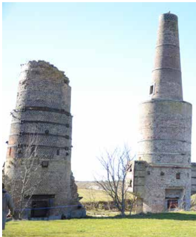
De bevaringsværdige skorstene
